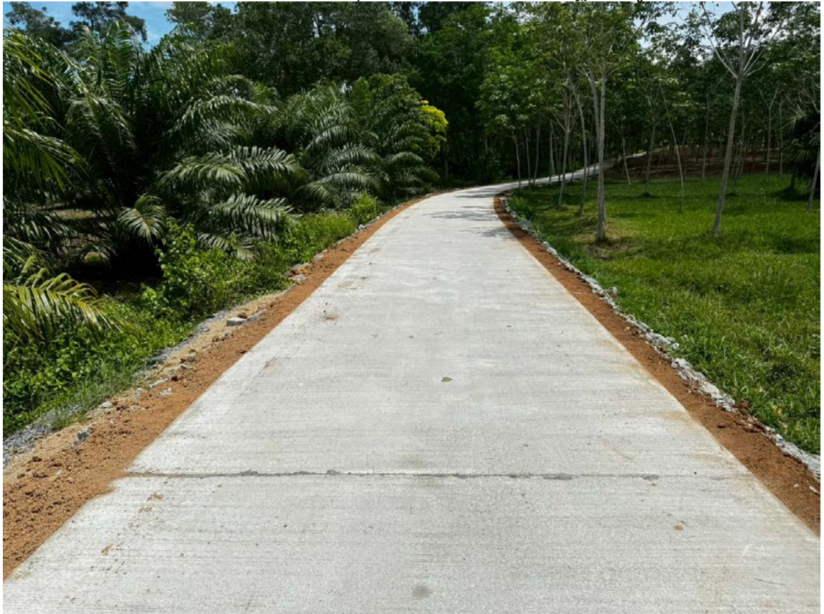
โครงการก่อสร้างถนน คสล.ริมทุ่ง - บ้านนายประเสริฐ หมู่ที่ ๕
